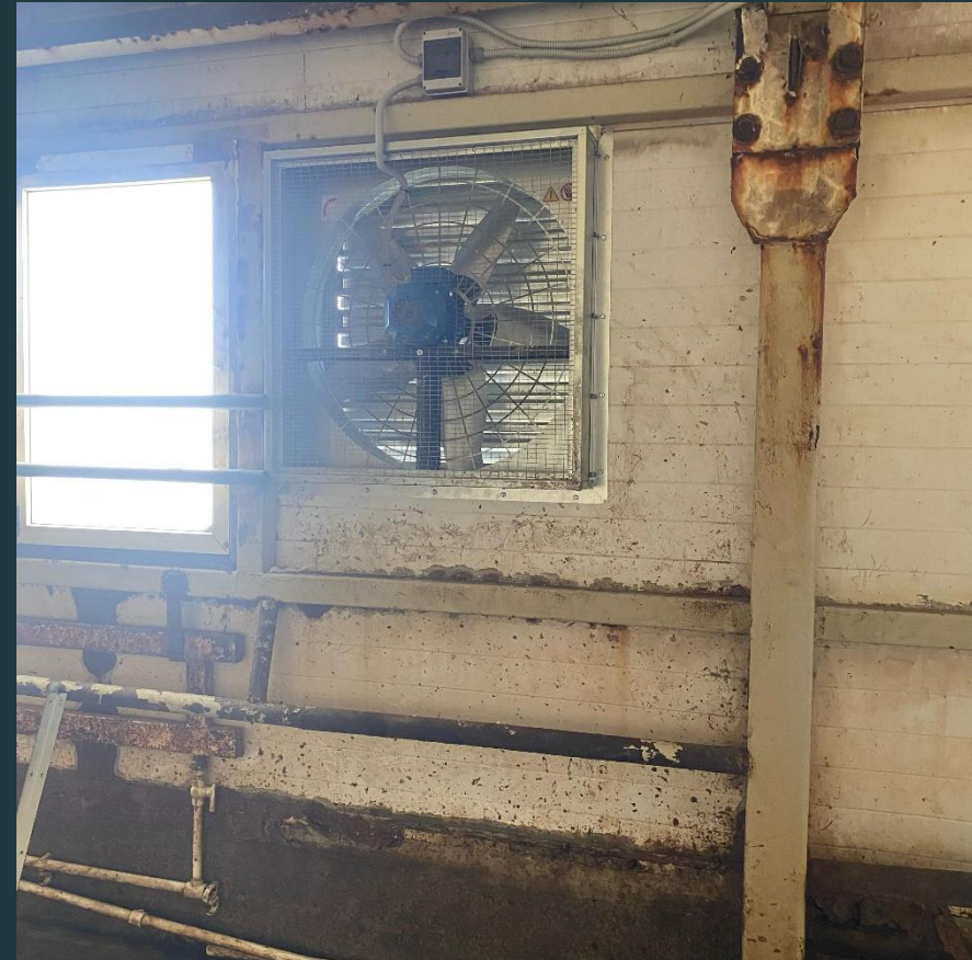
Вытяжные вентиляторы с инерционными шторами (жалюзи)
