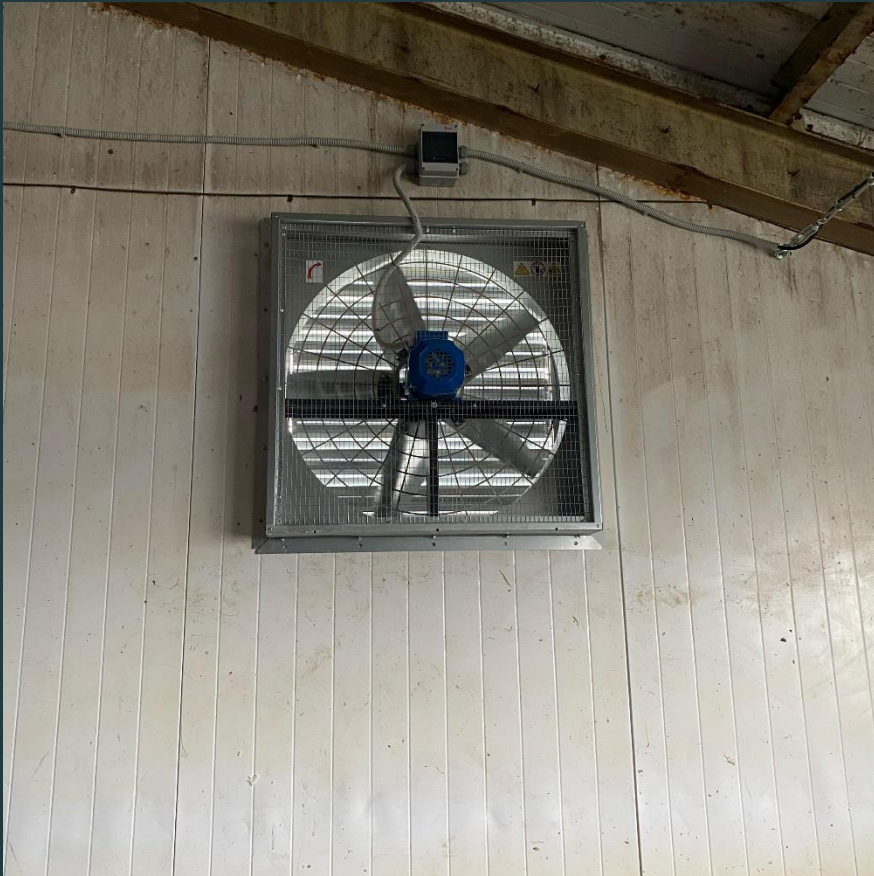
Вытяжные вентиляторы с инерционными шторами (жалюзи)
